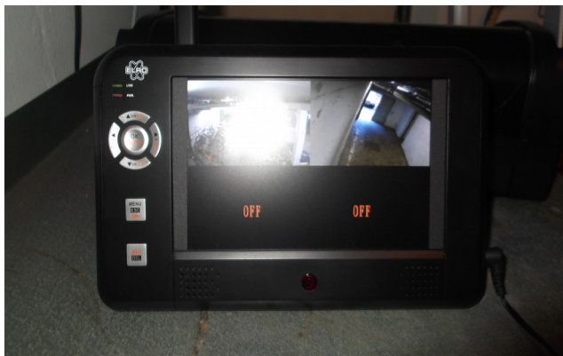
Überwachungsmonitor im Nebenraum
